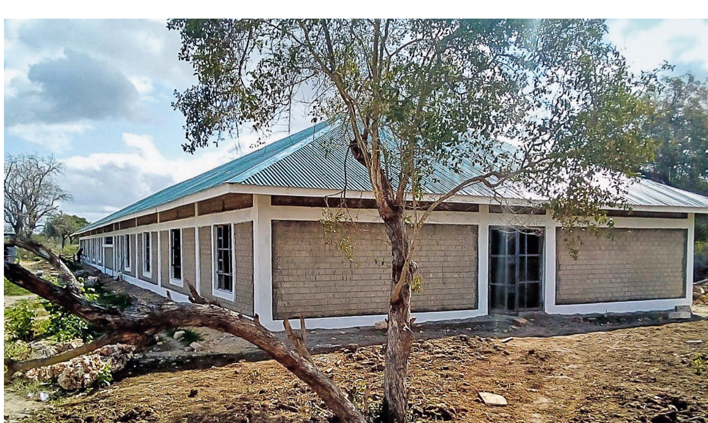
Das im Jahr 2021 fertiggestellte Mädchenwohnheim bietet 234 Schülerinnen eine sichere Unterkunft und ermöglicht ihnen einen regelmässigen Schulbesuch.
