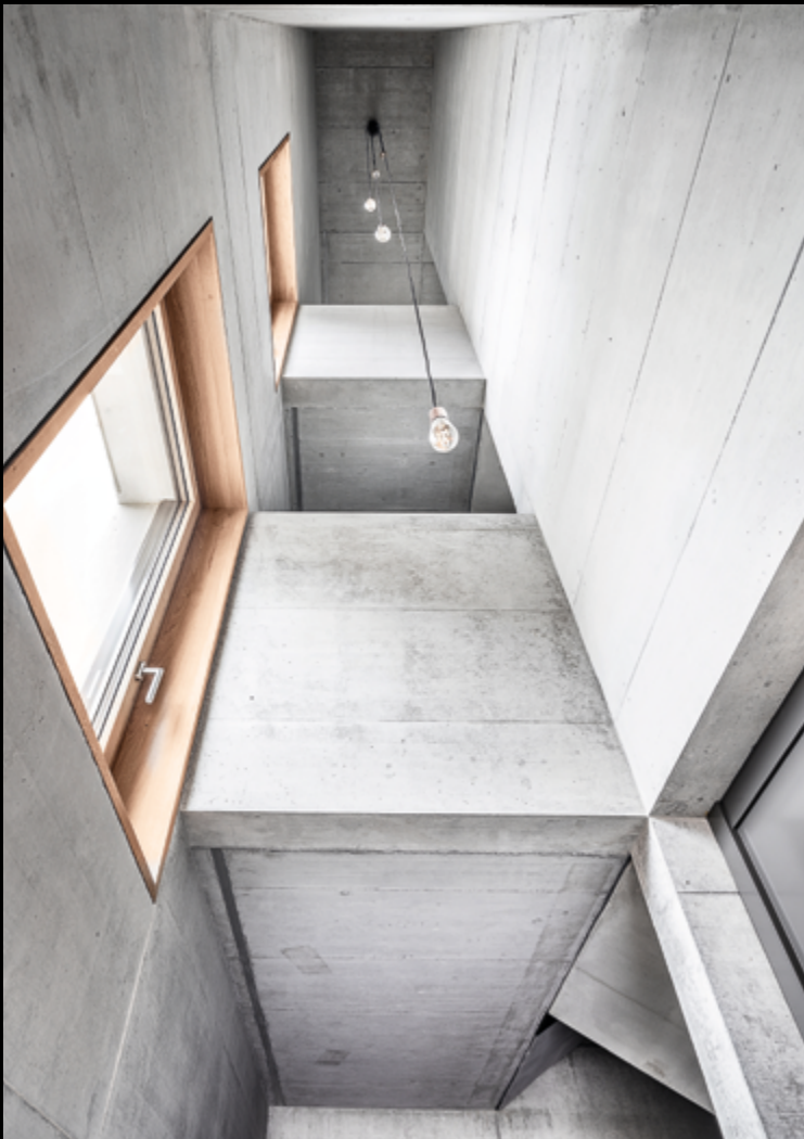
Mehrfamilienhaus, Luzerner Seetal . 2018 Sichtbetonfassade mit Kalksteinbeton erstellt. Licht- und Schattenspiel wird durch den Einsatz von Matrizen verstärkt. Treppenhaus und Attikawohnung ebenfalls in Sichtbeton ausgeführt. Architektur: Dolmus Architekten, Luzern Fotografie: Aytaç Pekdemir, Zürich
