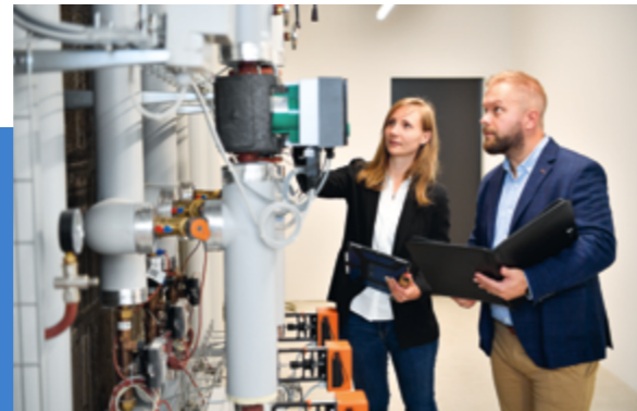
Tanja Stucki und Patrik Stirnimann bei der Besichtigung eines sanierungsbedürftigen Gebäudes. Unser Umbauteam erarbeitet individuelle Sanierungskonzepte.
