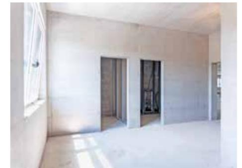
Alle Innenwände sowie das Treppenhaus wurden mit ressourcenschonendem Recyclingbeton mit kB erstellt. Der Rohbau wurde im März 2025 abgeschlossen, derzeit laufen der Innenausbau und die Umgebungsarbeiten. Die Fertigstellung ist für Ende 2025 geplant.
