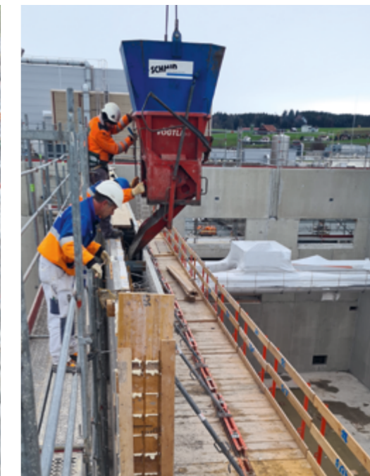
Doppel- und Thermowände: Die vorgefertigten Betonelemente wurden armiert angeliefert und mittels Anschlussbewehrungen miteinander verbunden. Auf der Baustelle wurden über 200 Doppelwandelemente versetzt und die Hohlräume mit Beton vergossen.
