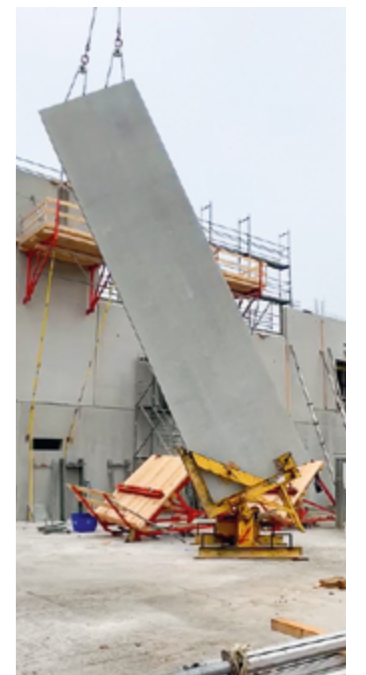
Das höchste Einzelelement misst 9.80 Meter – das schwerste wiegt 8.8 Tonnen.
