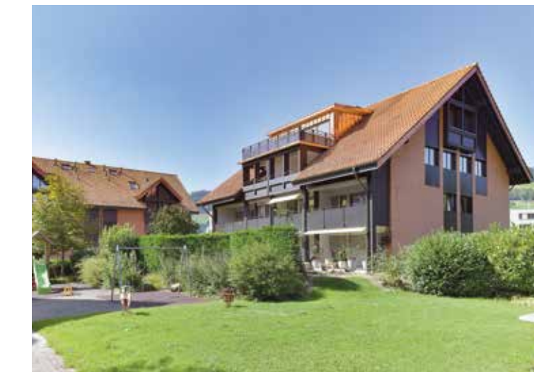
Wichlernweg, Kriens . 2016 – 2017 3 Mehrfamilienhäuser mit 27 Wohneinheiten | Totalsanierung
