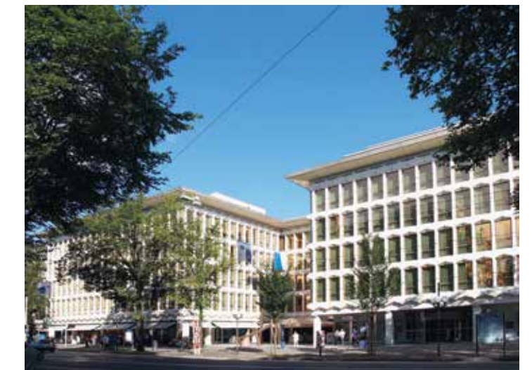
Luzerner Kantonalbank, Luzern . 2008 – 2016 Bankgebäude | Aussen- und Innensanierung
