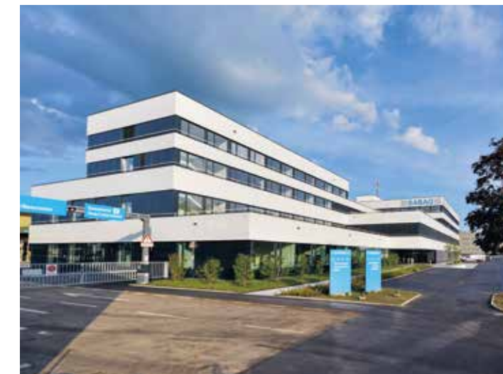
SABAG, Rothenburg . 2014 – 2016 Ausstellungs- und Verwaltungsgebäude | Totalsanierung
