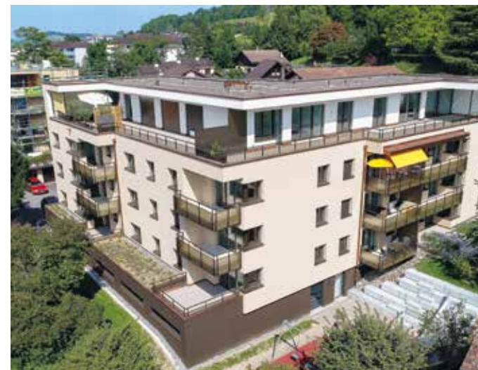
Grepperstrasse, Küssnacht am Rigi. 2016 – 2017 Mehrfamilienhaus mit 14 Wohneinheiten | Totalsanierung mit Aufstockung
