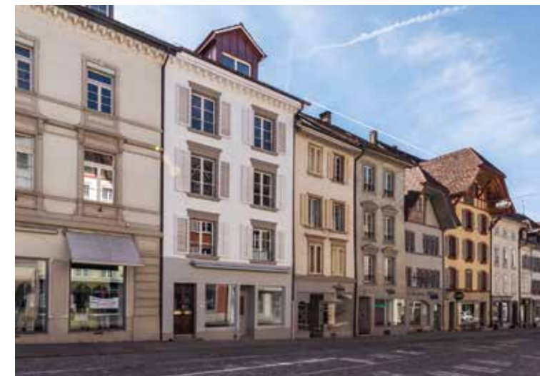
Vordere Vorstadt, Aarau . 2016 – 2017 Stadthaus mit 3 Mietwohnungen und einem Dachstudio | Totalsanierung
