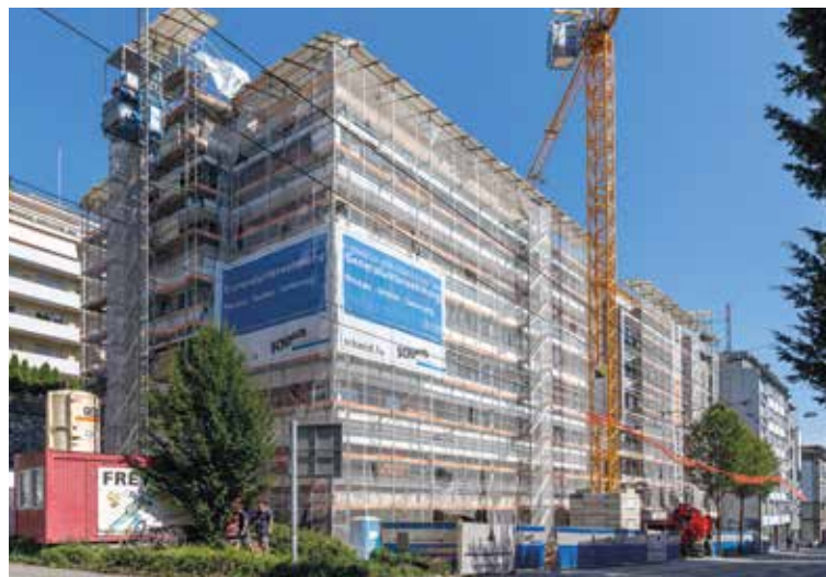
Wesemlinstrasse, Luzern . 2017 – 2019 2 Mehrfamilienhäuser mit 74 Wohneinheiten, 50 bis 345 m 2 Verkaufs- und Büroflächen | Totalsanierung
