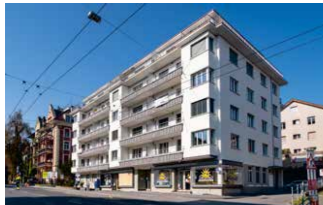
▲ Das Gebäude im beliebten Maihofquartier nach der subtilen Totalsanierung.
