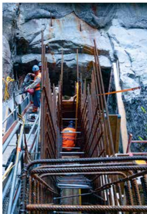
▲ Viel Handarbeit unter engsten Platzverhältnissen verlangt viel Kraft.
